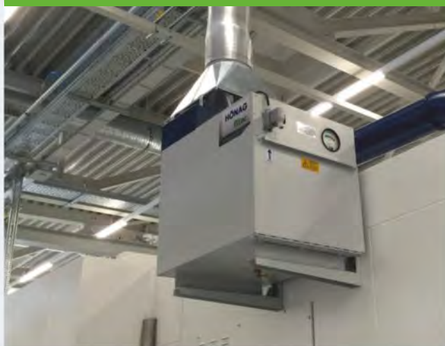
HÖNAG 1500 vor Lüftungsanlagen ohne öldichte Verrohrung möglich
